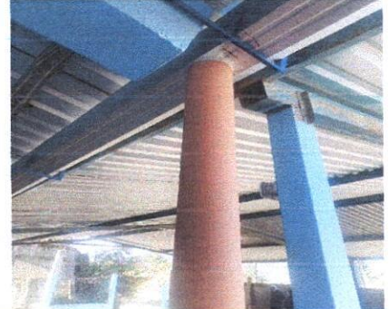
Foto 10: Finalizacion de la sustitucion de bajada de agua plubial
