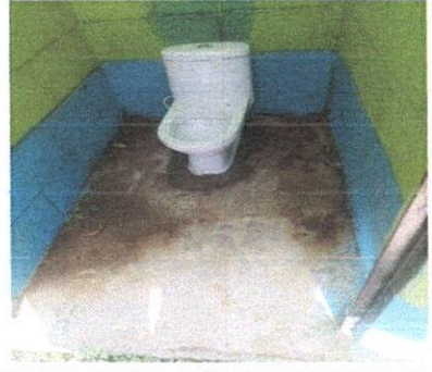
Foto 8: Finalizacion de la sustitucion de loza sanitaria
