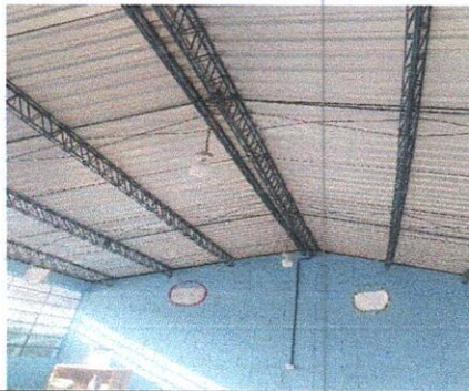
Foto 3: Finalización de reparación del sistema eléctrico
