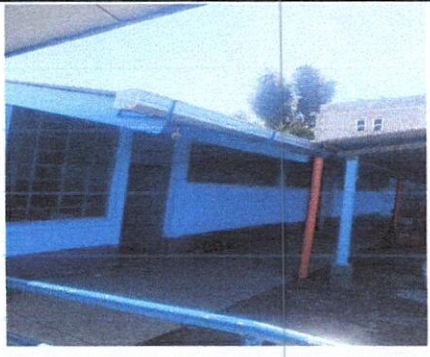
Foto 7: Finalizacion de la sustitucion de canales
