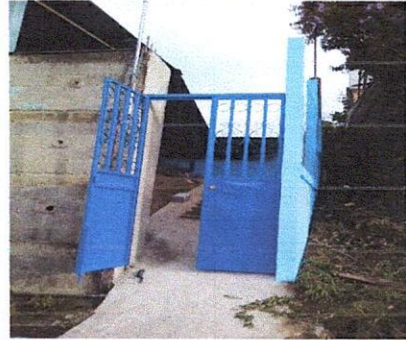
Foto 2: Finalización de instalación del portón de metal
