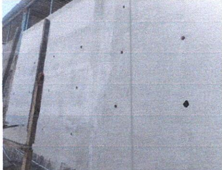
Foto 9: finalizacion de repello de muro
